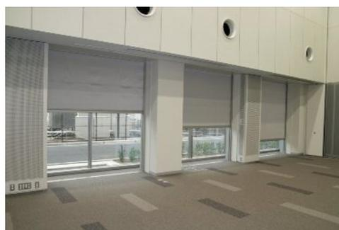
図 2 電磁波遮蔽ロールスクリーン
